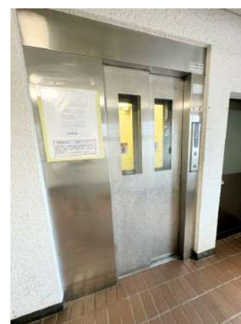
エレベーター
